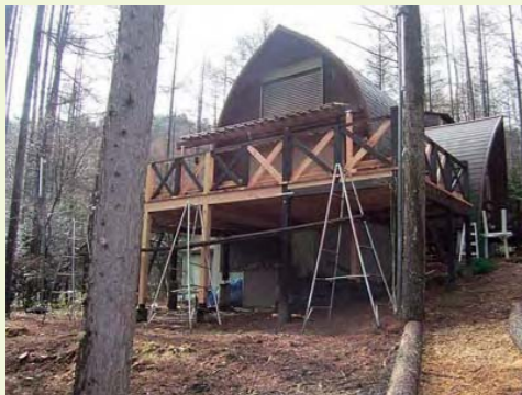
ベランダ改修と共に前方の見晴らしを良くし、日の光を取り込む工事をしました。必要な木を残し、間伐材を利用して通路を作成しました。
